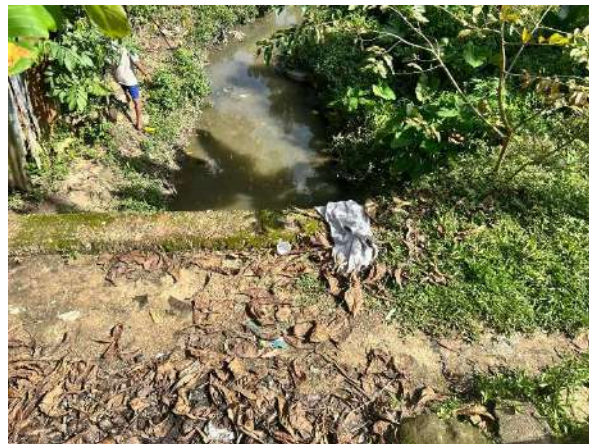
Foto 4. Estado del Box Culvert calle 3 con carrera 6 y 11
