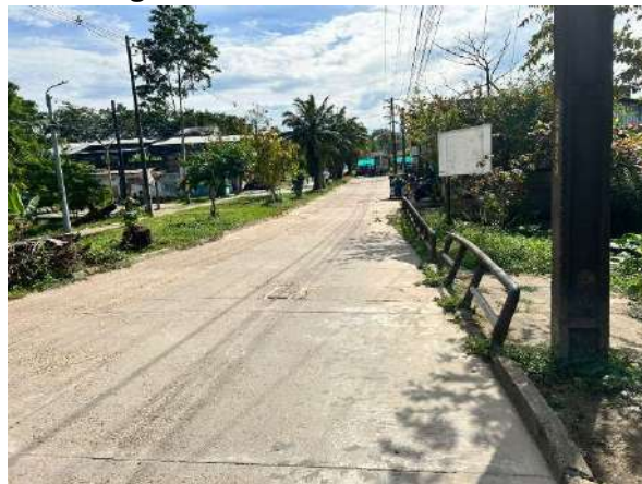
Foto 1. Estado del Box Culvert calle 3 con carrera 6 y 11
