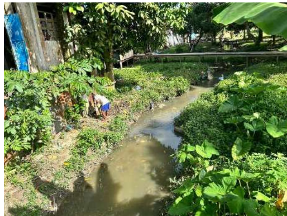
Foto 2. Estado del Box Culvert calle 3 con carrera 6 y 11
