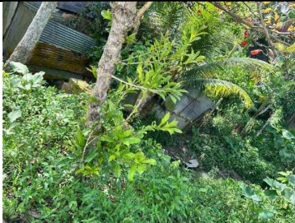
Foto 6. Estado del Box Culvert calle 3 con carrera 6 y 11
