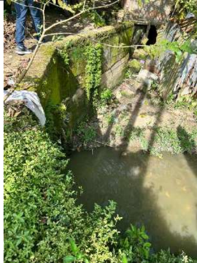
Foto 3. Estado del Box Culvert calle 3 con carrera 6 y 11
