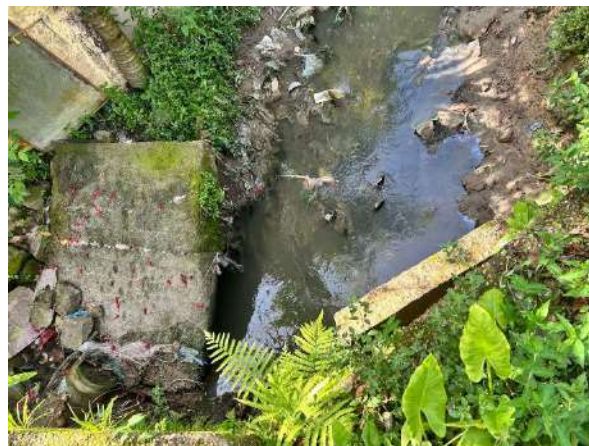
Foto 5. Estado del Box Culvert calle 3 con carrera 6 y 11
